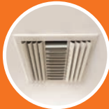
Sellado de aire y conductos
